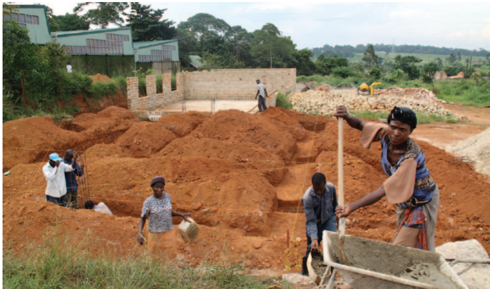
Lokale bouwvakkers werken aan de fundering van het gebouw
