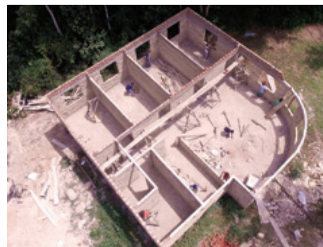
▲ De volgende Family Unit in aanbouw
